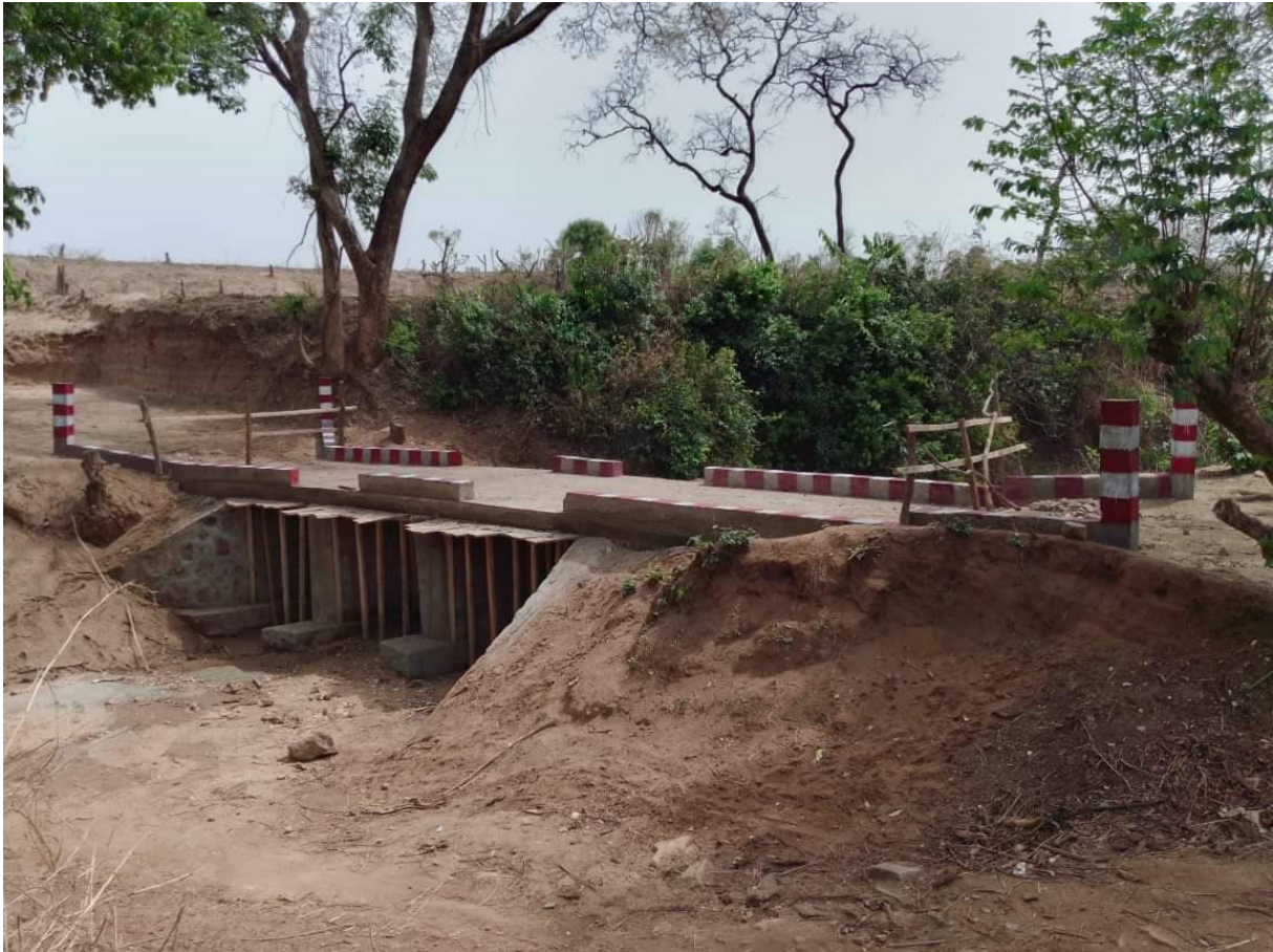
Nystøpt bru over Mayo Daki
